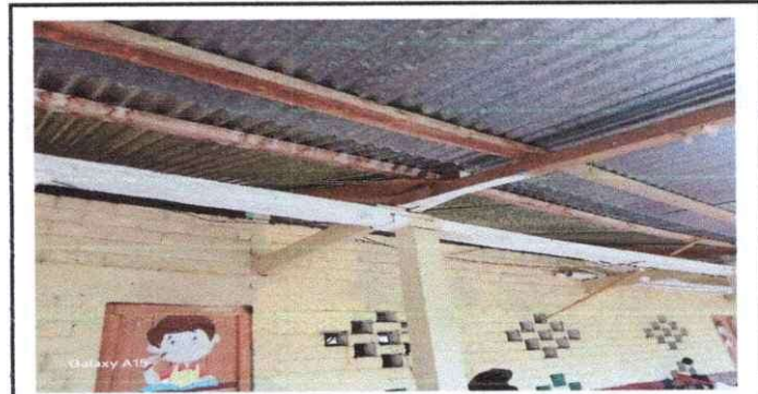
Foto 6: Sustitución de vigas por costaneras, en el área del corredor.
