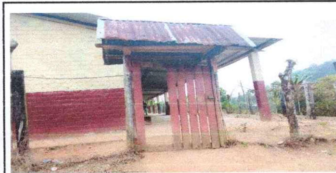
Foto 3: Sustitución de puerta de ingreso por una de metal.
