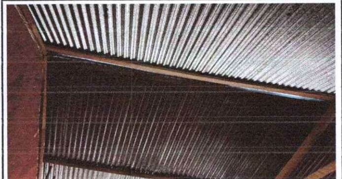
Foto 2: Se puede observar que las vigas de madera están deterioradas, se pretende la sustitución por costaneras.
